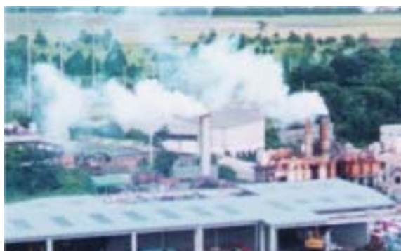
厚木基地でのダイオキシン類汚染(後方は滑走路) 隣接した産廃焼却施設からの排煙
